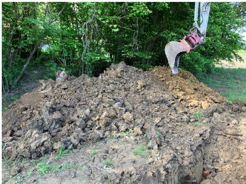
**Bild 4: Aushubmaterial aus Schurf 1**
