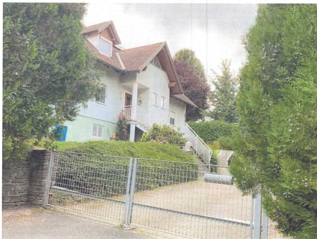
Abb. 7 - Gebäude „Stadtbergen 149“ - Zweifamilienwohnhaus
