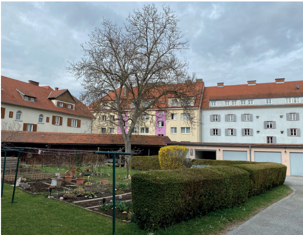
Abb. 3: Innenhof mit Einbauten
