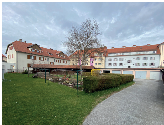
Abb. 2: Innenhof mit Einbauten
